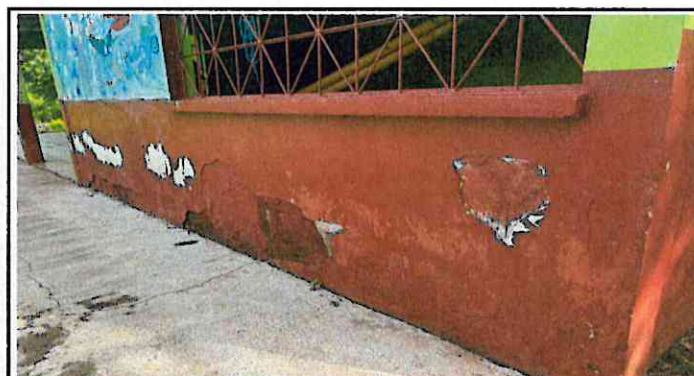
Foto 4: Reparación de repello de paredes interior y exterior.
