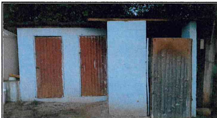
Foto 1: Sustrucción de puertas de lamina por puerta de metal.
