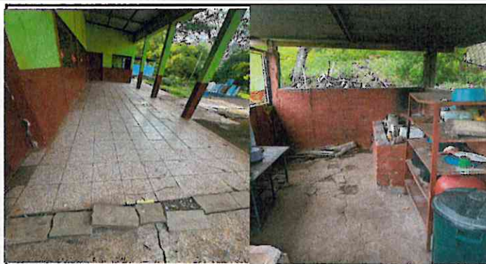
Foto 2: Sustrucción de piso (salones y cocina)
