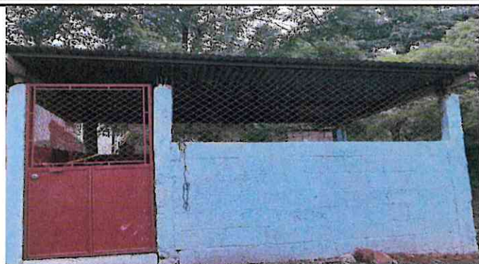
Foto7: Sustitución de lamina. (cocina y baños).
